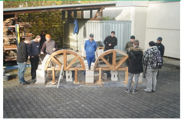
Anfertigen eines Rundbogens aus Mauersteinen im Hochbau
