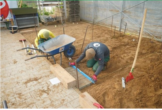
Herstellen einer Wegfläche in der GalaBau-Halle
